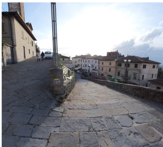
17 Rampa per tornare su Via Montalbano
