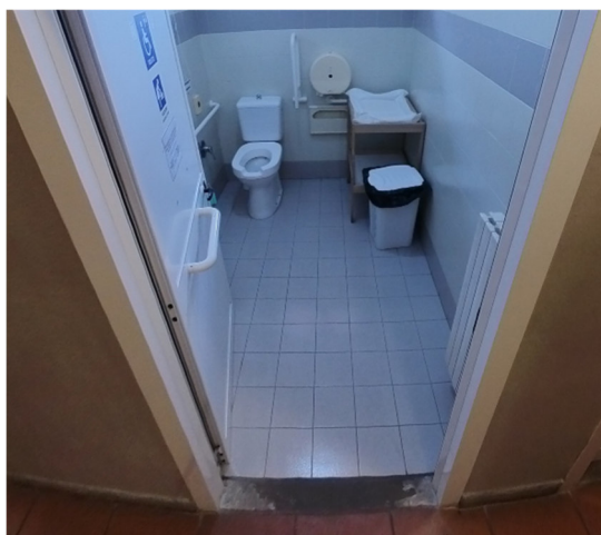
27 interno servizi igienici Palazzina Uzielli
