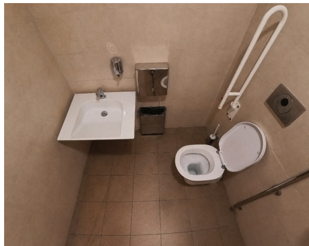
31 interno servizi igienici Casa di Leonardo
