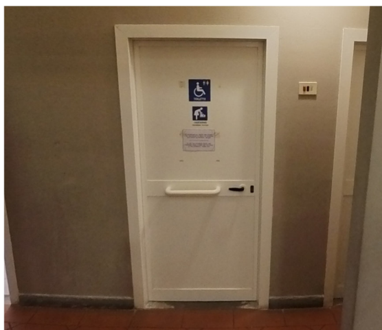
26 porta servizi igienici Palazzina Uzielli
